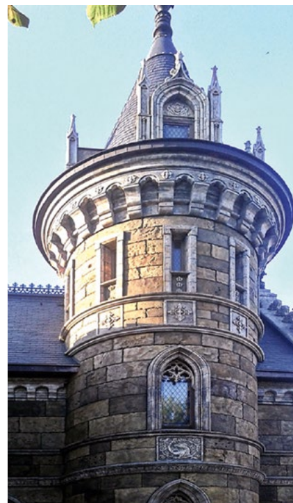
Облицовка замка Гарибальди (Самарская обл.) выполнена из композита по технологии вмазывания формовочной каменной смеси в форму
