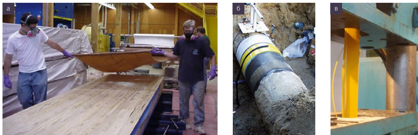
Рисунок 8. а — укладка пропитанной стеклоленты на элемент деревянного моста [23]; б — ремонт нефтепровода «Гомельтранснефть Дружба» с применением стеклопластиковой ленты Clock Spring; в — испытания Clock Spring в Полоцком университете [24]
