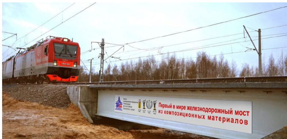
Рисунок 10. Цельнокомпозитное пролетное строение под железнодорожную нагрузку компании ООО НПП «АпАТЭК»: длина пролета — 11,5 м, ширина — 3,2 м, общая высота до головки рельса — 2,03 м, масса — 15,95 т, нормативная нагрузка — С14 (Фото: gudok.ru )
