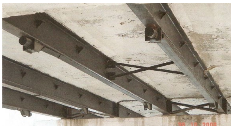
Рисунок 5. Пример усиления сталежелезобетонного пролетного строения напрягаемой стеклопластиковой арматурой (Фото: презентация ФГБОУ ВО СГУПС Сибирский научно-исследовательский институт мостов)
