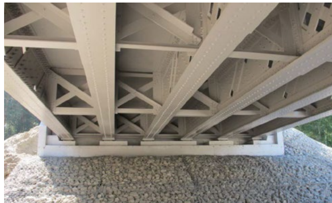
Рисунок 8. Первый автомобильный мост с композитным пролетным строением через реку Пашенка, Новосибирская обл. Слева — общий вид, справа — Конструкция пролетного строения, вид снизу (Фото: презентация ФГБОУ ВО СГУПС Сибирский научно-исследовательский институт мостов)
