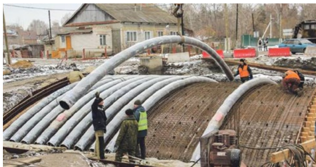
Рисунок 9. Строительство моста с применением углепластиковых арок (Фото: uralakademia.ru , m.aftershock.news )
