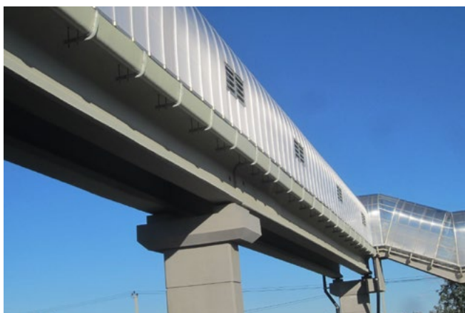
Рисунок 2. Пример установки подвесных фасадных лотков из композитных материалов (40 км трассы М20, Ленинградская область, фото: презентация ООО «Композит Групп»)
