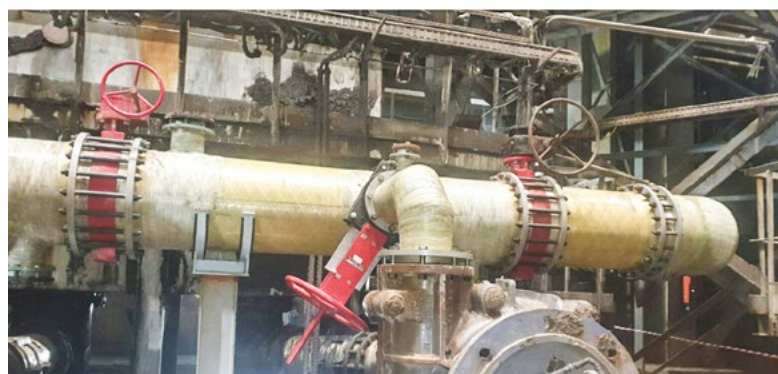
Первый трубопровод с футеровкой из керамики, сентябрь 2020
