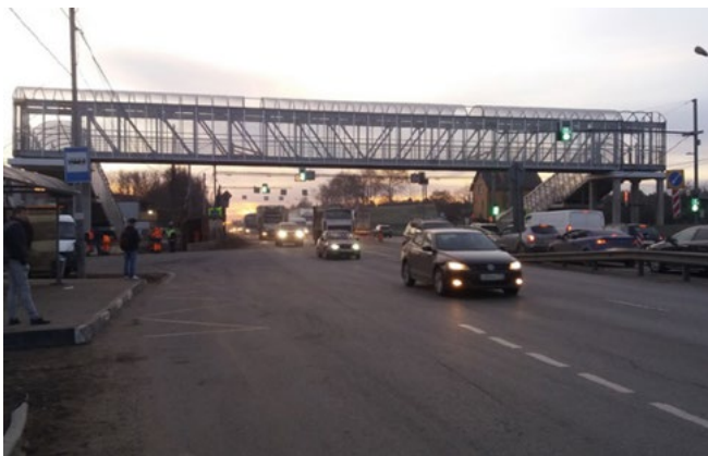
Рисунок 6. Пролетное строение из композиционных материалов пешеходного моста на 33 км автотрассы М-7 «Волга» (Фото: ООО НПП «АпАТЭК» www.apatech.ru )
