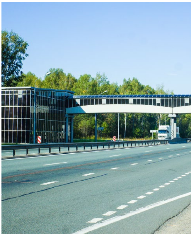
Рисунок 7. Цельнокомпозиционный пешеходный путепровод, проходящий над федеральной трассой М1 (251 км трассы Москва-Минск, фото: ООО УК «РУСКОМПОЗИТ» www.ruscompozit.com )
