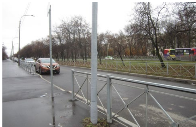
Рисунок 4. Композитная опора для уличного освещения, изготовленная ООО «Композит Групп» по заказу СПб ГБУ «ЛЕНСВЕТ» (установлена в Санкт-Петербурге на улице Гагарина, 14, Фото: презентация ООО «Композит Групп»)
