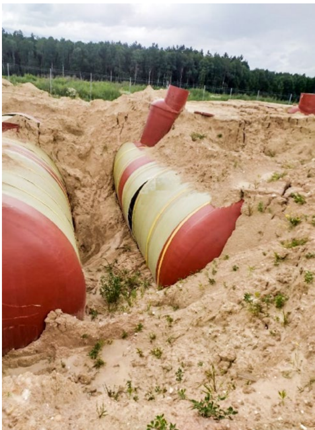
Рисунок 4. Разрушение ламината по ребру жесткости
