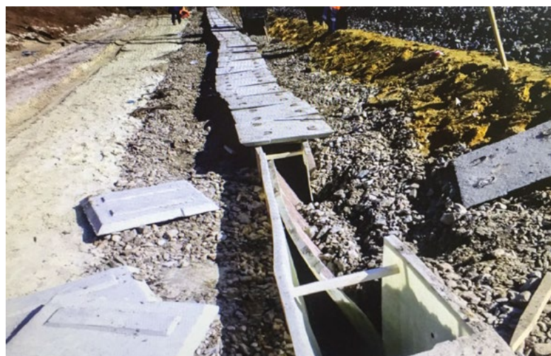
Рисунок 1. Разрушение при монтаже стеклопластиковых лотков, изготовленных из несоответствующих назначению изделия связующих
