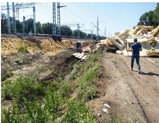
Рисунок 1. Разрушение при монтаже стеклопластиковых лотков, изготовленных из несоответствующих назначению изделия связующих
