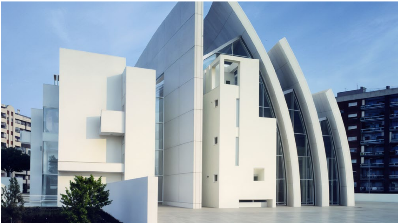
Рисунок 3. В конструкции церкви «Щедрый в милосердии» в Риме использованы наноматериалы, отталкивающие пыль и грязь
