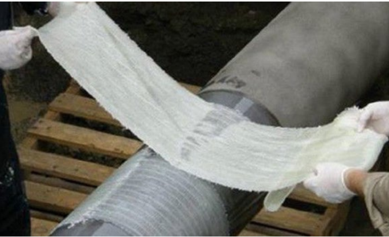
Фото 4. Ремонт трубопровода
