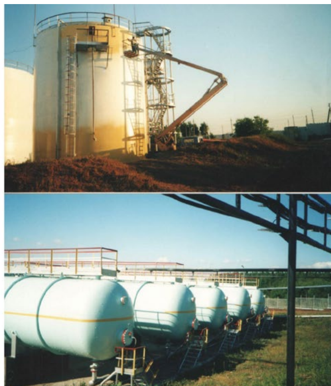
Фото 2. Объекты нефтеподготовки покрытые химстойкими ЛКМ
