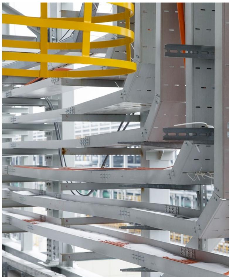
▲ Композитные конструкции. Кабельная галерея.
